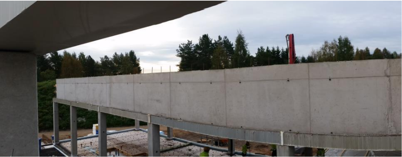
2. kerroksen kantavan betoniseinä
