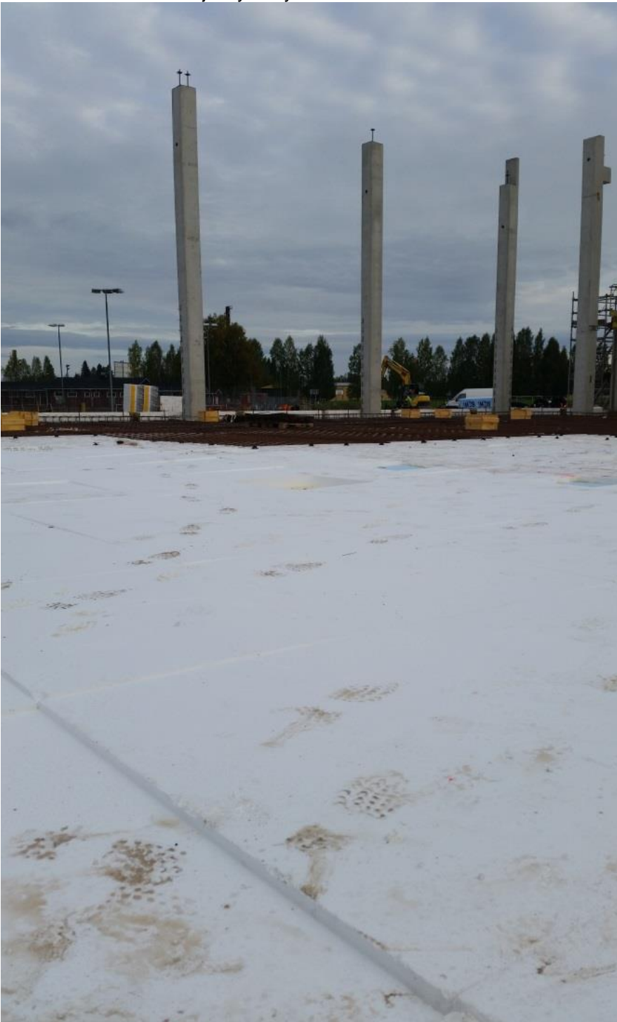
Liikuntahallin raudoitus- ja styrox-työt
