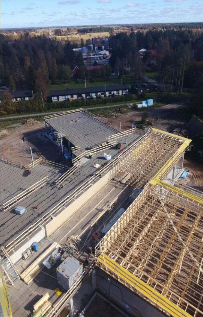
Kuva 2. Vesikaton runko valmistuu
