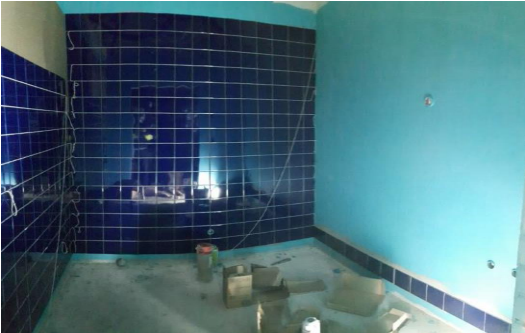
Opettajanhuoneen wc:n seinän laatoitusta.
