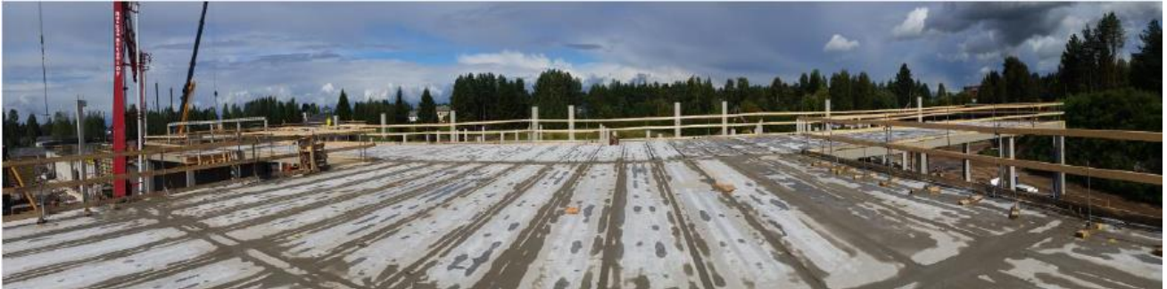
Kuva 1. Taito- lohkon ontelolaatat asennettu ja juotettu.
