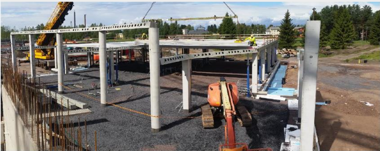
Kuva 2. 5-6-lohkon ontelolaatta asennus käynnissä.
