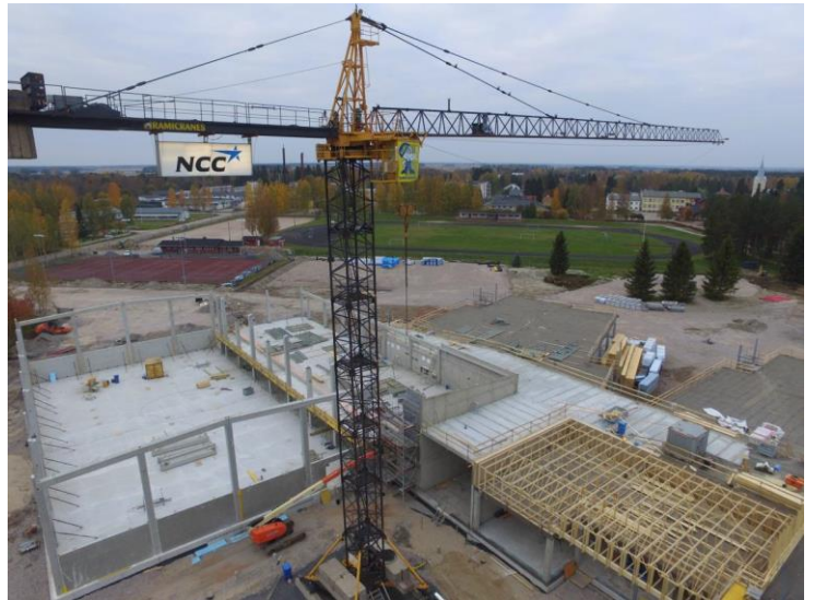
Kuva 2. Vesikaton runko ja 2. kerroksen betoniseinät nousevat
