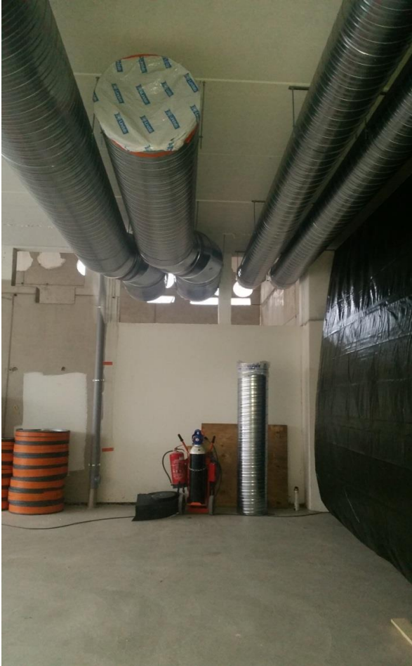
Kuva 1. Taito- lohkolla IV- runkoputkien asennus käynnissä
