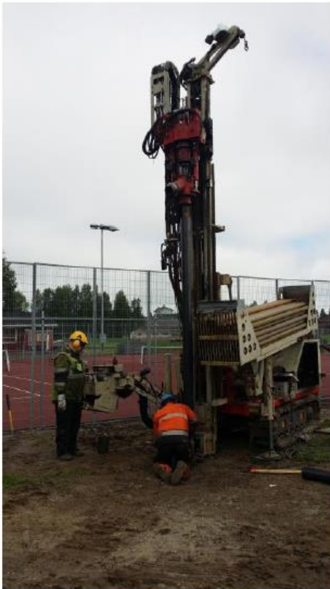
Maalämpökaivojen porausporukka täydessä työntouhussa.
